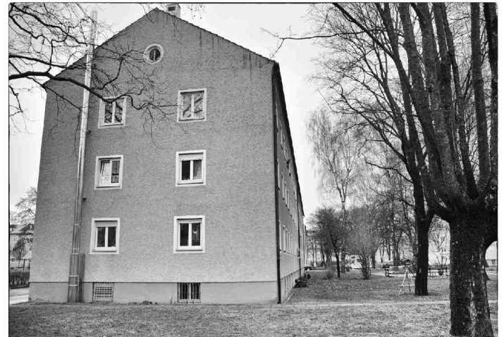
Trafohäuschen in der Amerstorfferstraße, Nähe Mangfallplatz, Anbau an früherem General Hospital, Lincolnstraße „Luftbrücken-Siedlung“ in deutscher Satteldachtradition an der Claudius- Keller-Straße in Neu-Ramersdorf.
